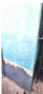
Foto 1: PINTURA EN MUROS INTERIOR Y EXTERIOR Preparación de la superficie y aplicación de pintura a dos manos, en paredes interiores y exteriores del establecimiento.
