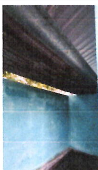
Foto 3: CUBIERTA DE LAMINA Sustitución de cubierta de techo con lámina galvanizada, Tipo de lamina: troquelada Calibre: 26, incluye: fijaciones y sellado en traslapes.
