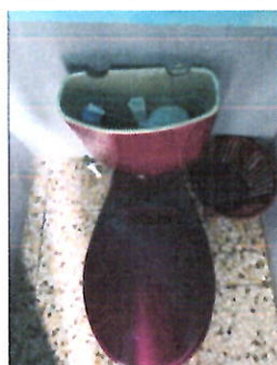
Foto 5: SERVICIOS SANITARIOS Y SUS ACCESORIOS Sustitución de sanitarios, incluye accesorios internos, externos, tapa y asiento
