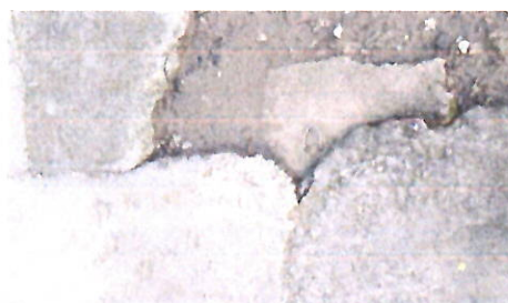
Foto 2: LOSA DE PATIO Reparación de losa de concreto para patios, considerando preparación de terreno, armado, nivelación y acabado rustico. En el area de ingreso
