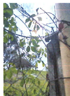
Foto 4: CERCO O MURO PERIMETRAL Sustitución malla de acero galvanizado en perímetro del establecimiento, con instalación fija y tensa, anclajes metalicos en intervalos regulares
